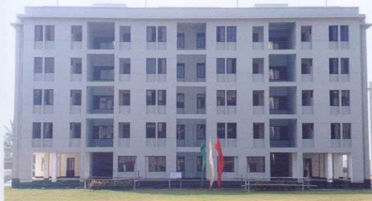
খুরুশকুল বিশেষ আশ্রয়ণ প্রকল্পে নির্মিত একটি বহুতল ভবন
